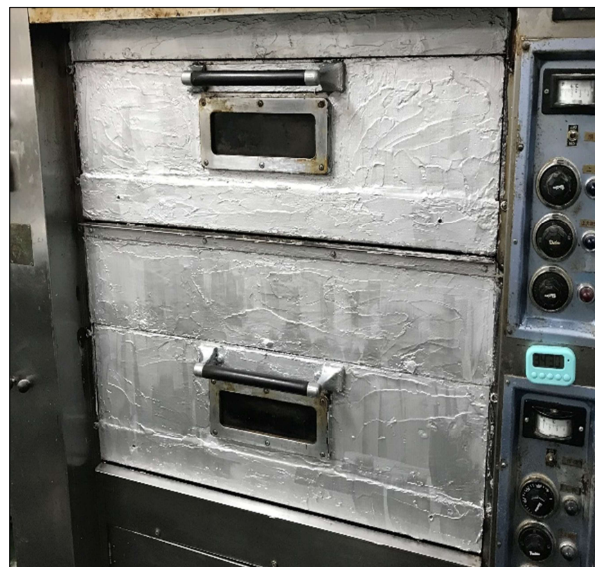
断熱塗料塗装後
