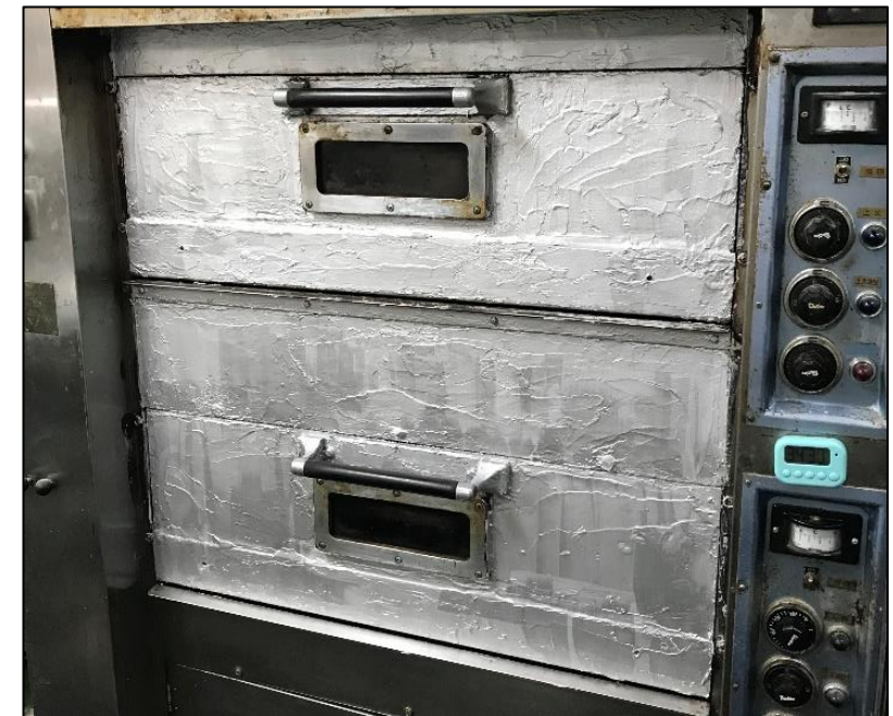
オーブンドア断熱塗料塗装後
