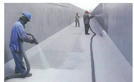
化学工場水路内面
