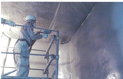
発電所ピット内面
