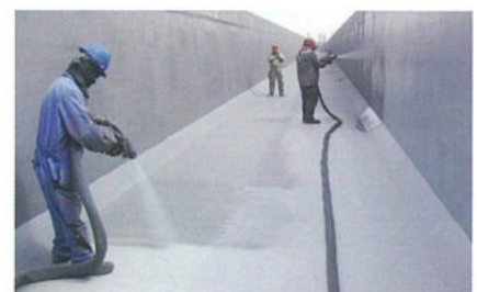
化学工場水路内面
