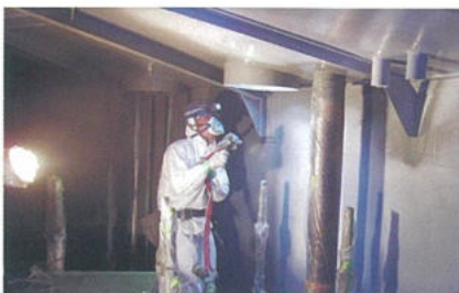
自動車工場タンク内面
