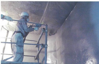
発電所ピット内面
