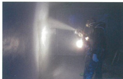
製鉄所排酸槽内面
